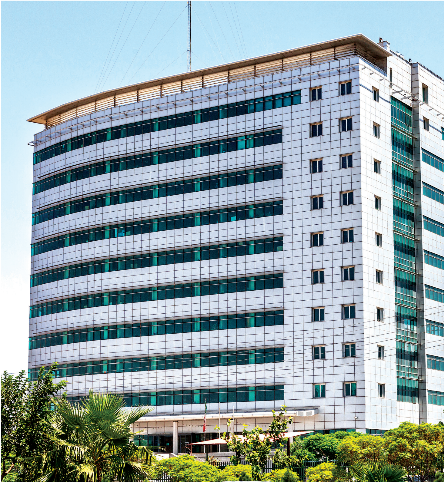
| ساختمان جهاد کشاورزی، استان قم |
